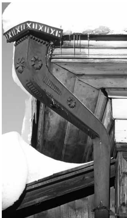
Кованая водосточная труба, сделанная на заводе. Фото из архива Н. А. Швецевой
