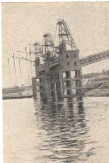
Современные средства портовой механизации — пневматические перегружатели.
