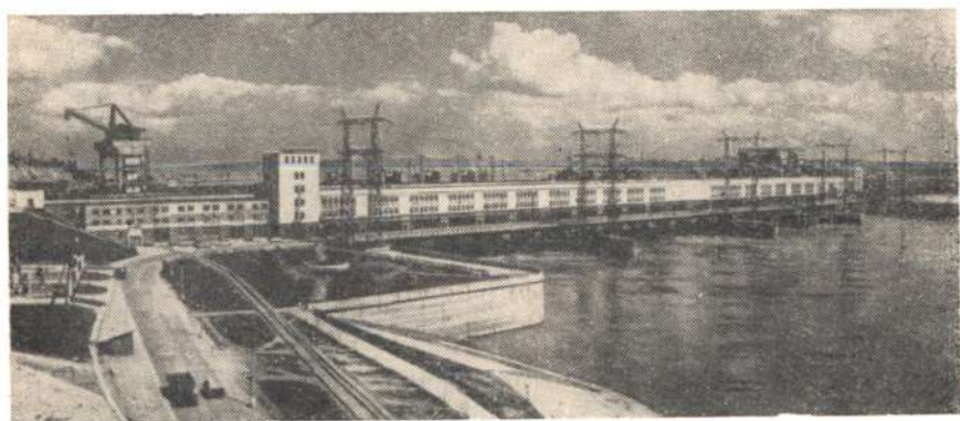
Первенец гидростроительства на Каме — Камская ГЭС.
