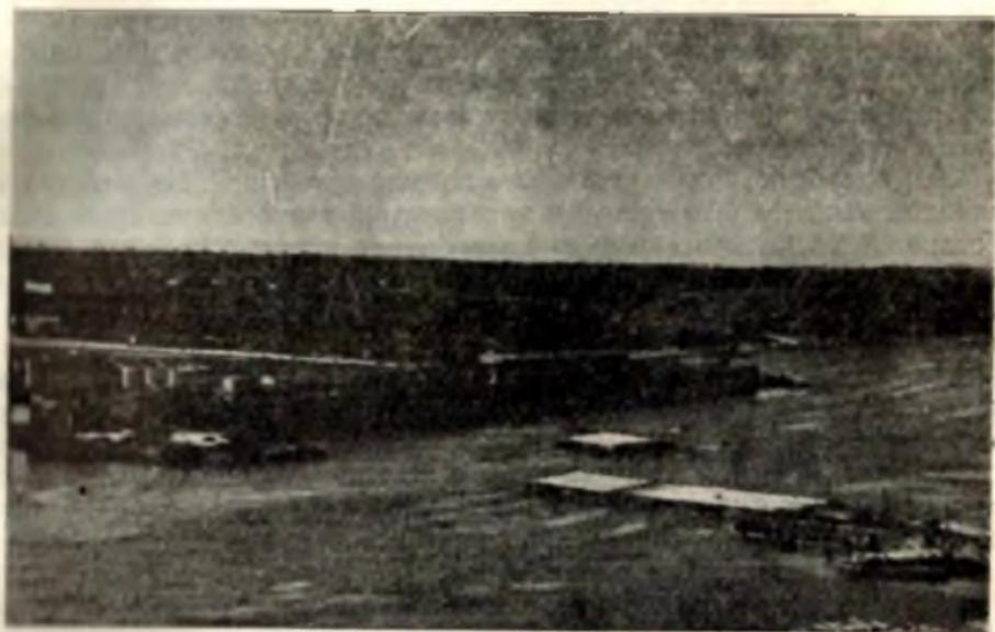
Чтобы перерезать свободную часть Камы, нужно было соорудить pontонный мост, с которого десятки мощных самосвалов могли бы сбрасывать в реку грунт, камень и специальные бетонные кубы. На снимке: наводка моста в сентябре 1953 года.
