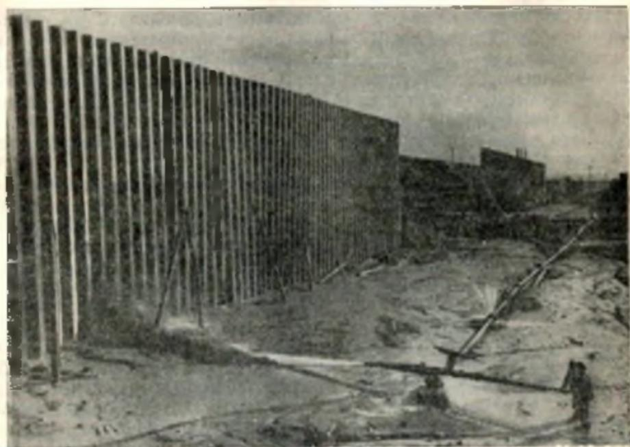
Для перемещения грунта на стройке успешно применялись гидромониторы.
