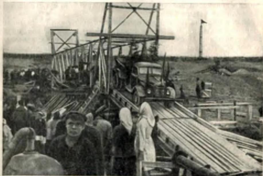
Подлинным производственным праздником для всего коллектива стройки явилась укладка первого кубометра бетона в основные сооружения гидроузла. На снимке: первая машина с бетоном для фундамента плиты гидроэлектростанция входит на бетоноукладочный мост (18 июня 1951 г.).
