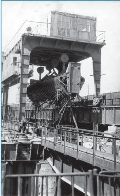
Расчистка топлого леса с сороудерживающихрешеток грейферным краном
