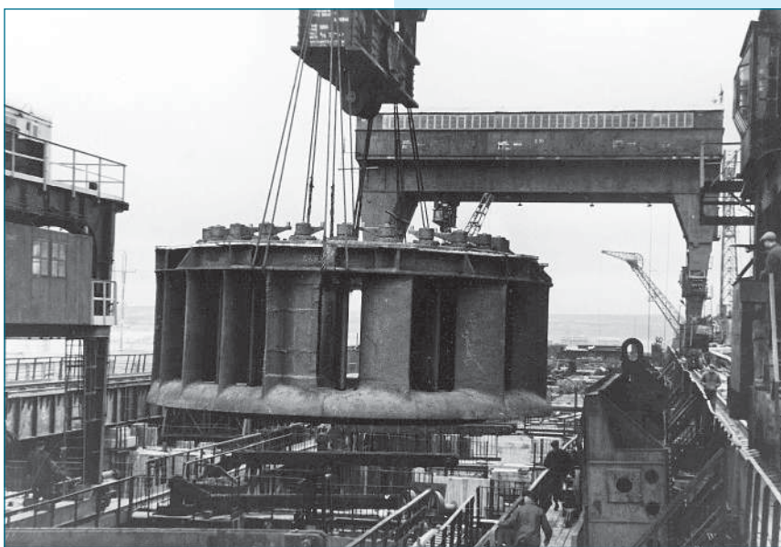
Монтаж направляющего аппарата
