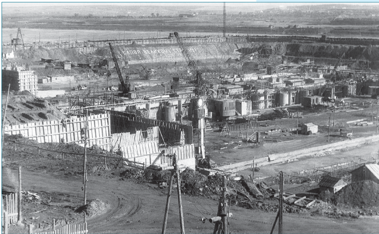
Общий вид котлована 1й очереди, 1952 год
