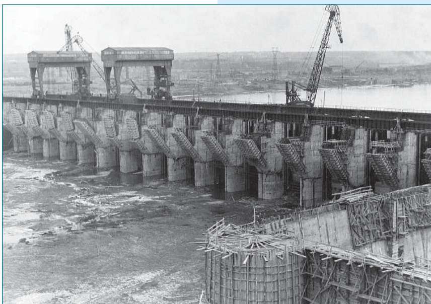
Опалубка консолей верхнего бьефа
