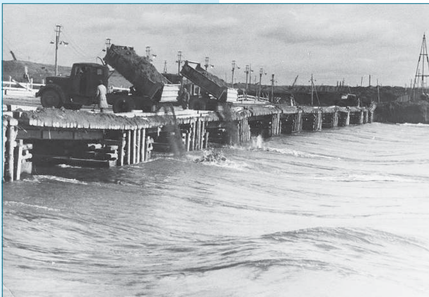
Перекрытие Камы. 6 октября 1953 года
