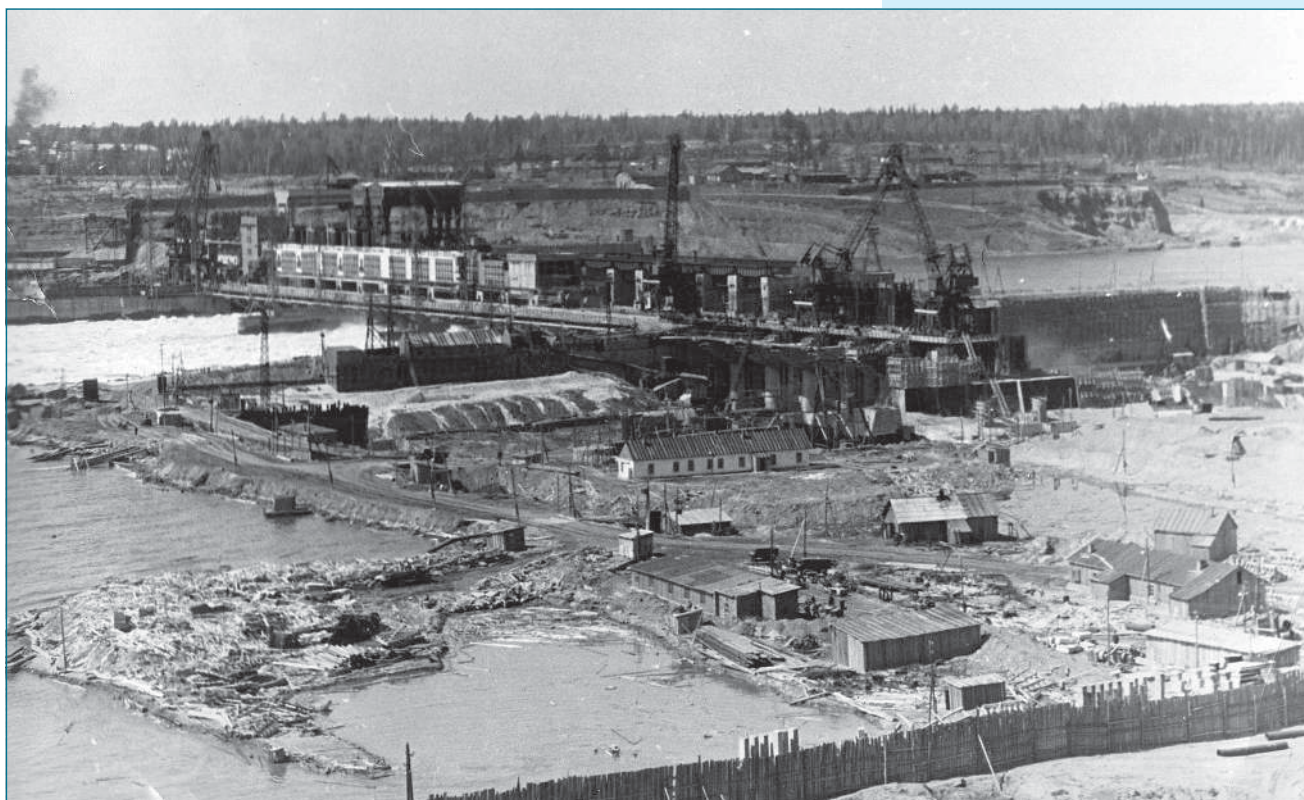
Котлован 2 й очереди, 1955 год
